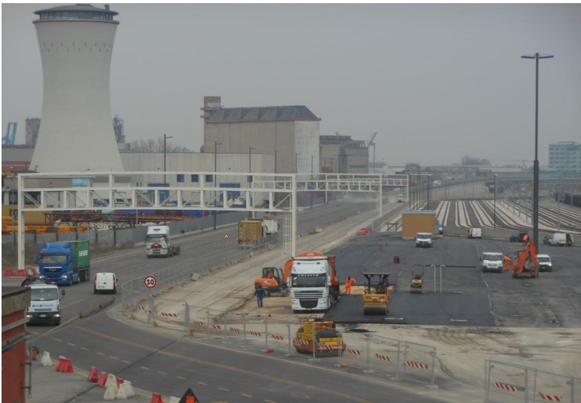
Lavori in via dell'Azoto
